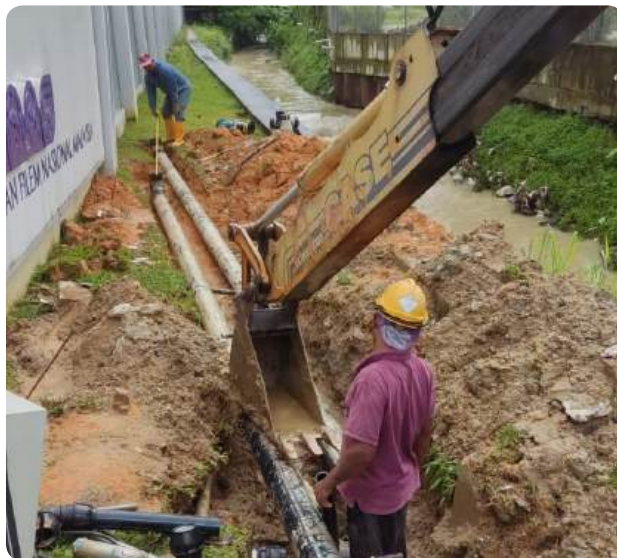
Kerja-kerja membuka, membekal dan memasang serta mengubah kedudukan stand meter untuk meter air supply dan pili bomba ke bangunan FINAS Hulu Kelang
