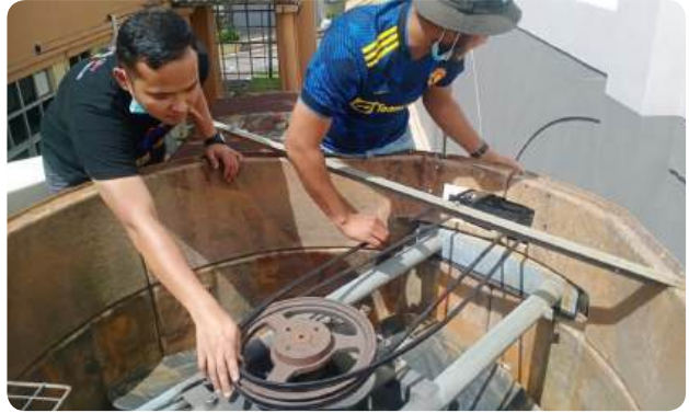
Kerja-kerja penyelenggaraan berkala Cooling Tower Studio Sound Stage FINAS Hulu Kelang
